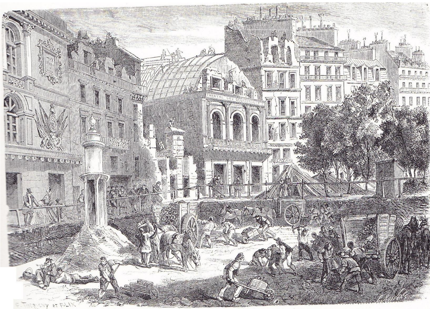
DÉMOLITION DES THÉÂTRES DU BOULEVARD DU TEMPLE POUR LE PERCEMENT DU BOULEVARD DU PRINCE-EUGÈNE.
